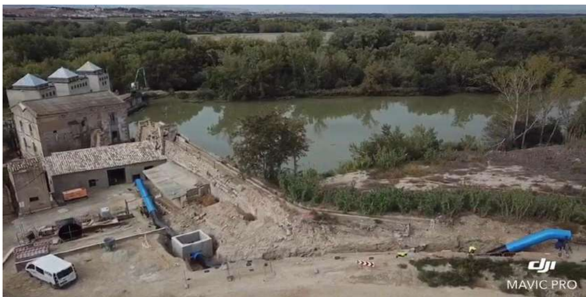
Tubería de impulsión y bombeo-turbinado de la obra de mejora y adaptación de las infraestructuras del sistema de regadío de la Comunidad de Regantes de la Huerta de Gelsa - Fase I
