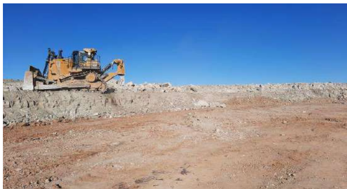
Trabajos de movimiento de tierras en el vaso de la balsa de la Portellada en Ontiñena(Huesca)
